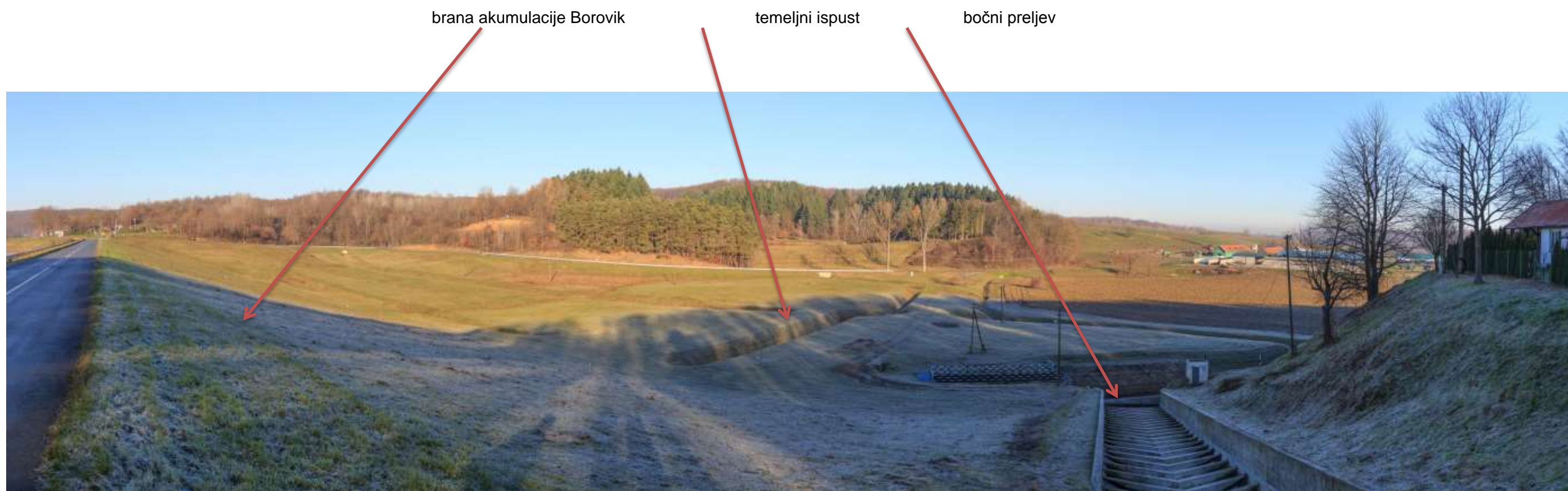
Slika 1-6 Panoramska fotografije brane akumulacije Borovik (nizvodno)
