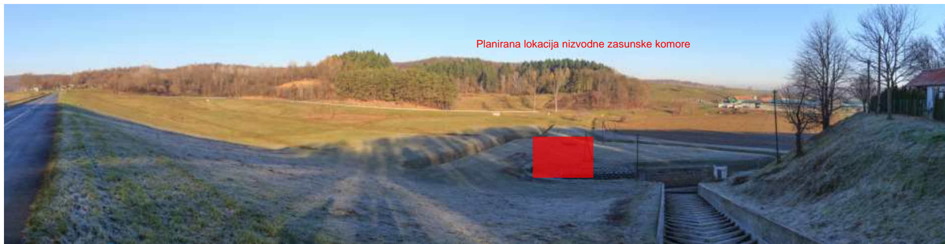
Slika 2-17 Lokacija planirane rekonstrukcije nizvodne zasunske komore (pogled s brane na sjever i dolinu Vuke). Vidljivi su postojeći kanali.
