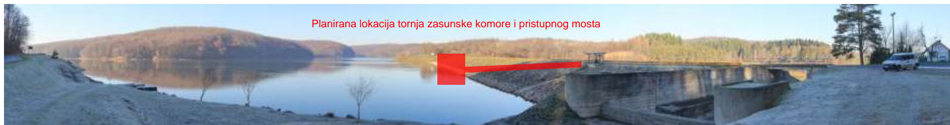
Slika 2-16 Lokacija planiranog tornja zasunske komore i pristupnog mosta uz branu (pogled sa sjeveroistočnog ruba akumulacije na zapad i akumulacijsko jezero Borovik)
