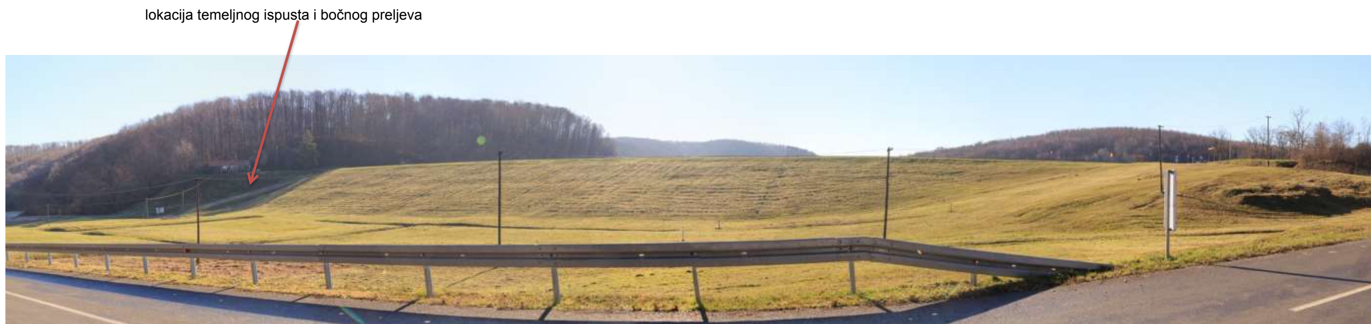
Slika 1-7 Panoramska fotografije brane akumulacije Borovik (nizvodno)
